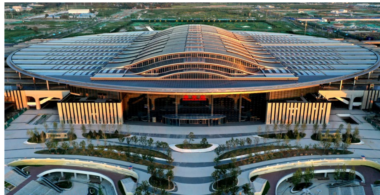
▲ 雄安新区高铁站站房屋顶分布式光伏
