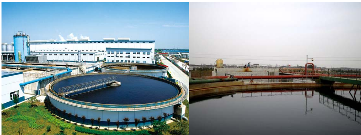
景兴纸业造纸废水处理工程
